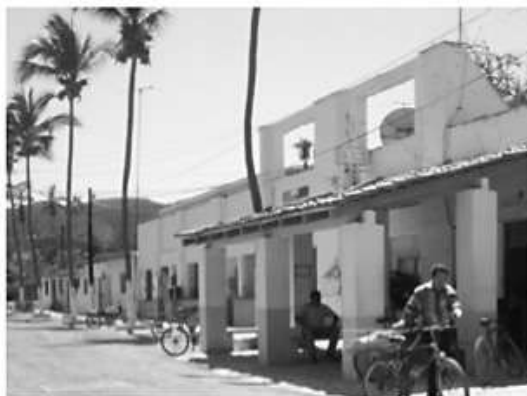
FIGURA 7. Pasaje urbano desde la avenida Morelos
