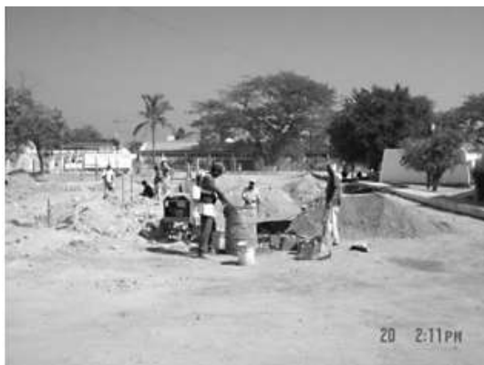
FIGURA 14. Internos trabajando en la construcción
