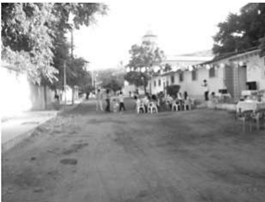
FIGURA 12. Pasaje urbano desde la calle Zaragoza
