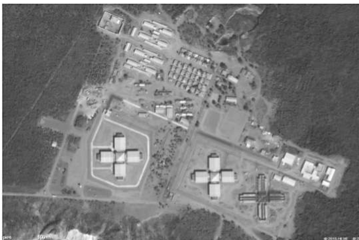
FIGURA 38. Centro Federal de Readaptación Social de Seguridad Máxima Laguna del Toro
